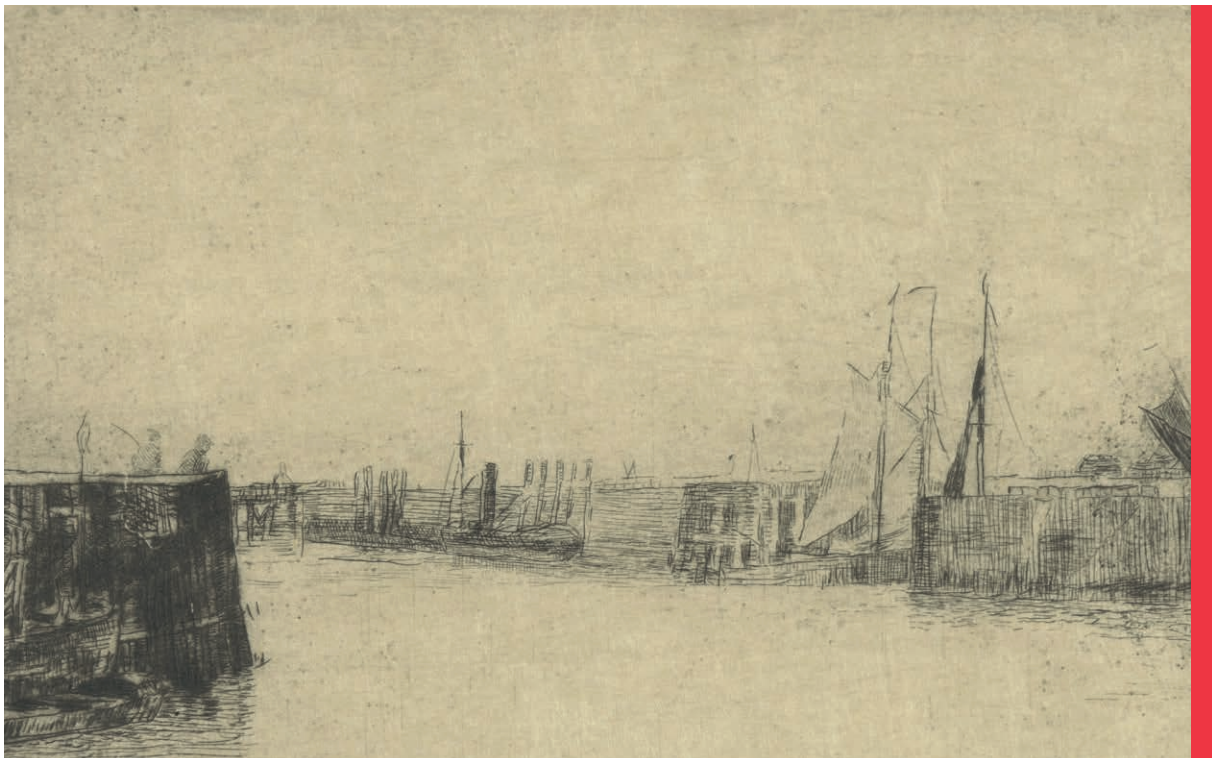
▲ "Staketsel - Pier te Oostende" Mu.ZEE Fotograaf: Cedric Verhelst
